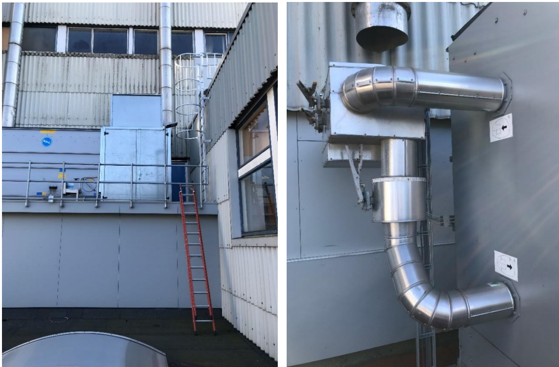
Figuur 2: de natte Baltimore koelmachine, met geluidsisolerende omkasting op het dak te midden van de hogere gebouwen
